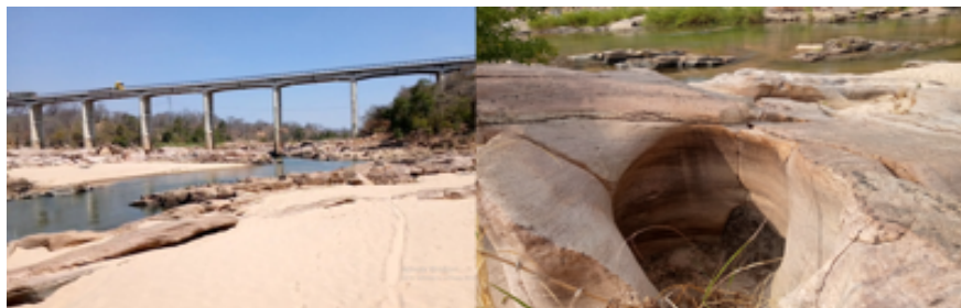
Figura 6: a) Ponte sobre o Rio Luenha; b) Afloramentos Rochosos e geoforma
